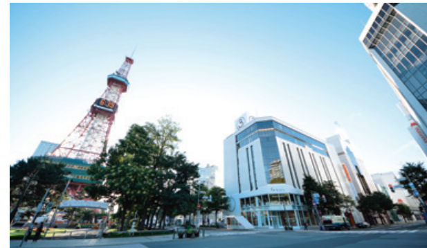
「Le trois (ル・トロワ)」外観
